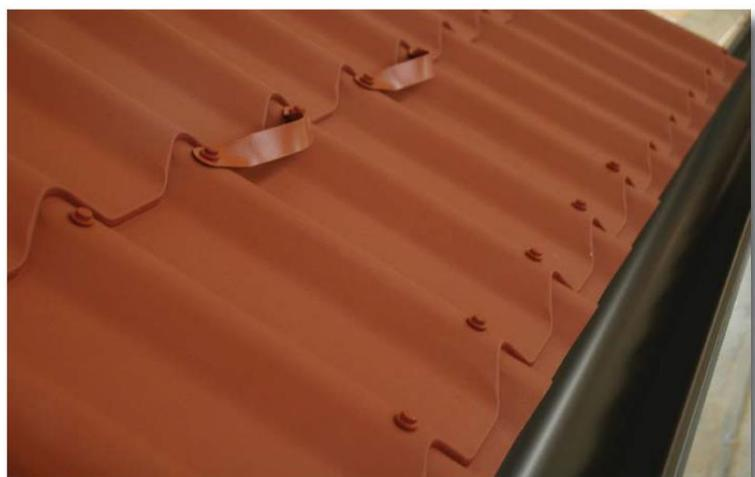
Abbildung 5: Verschraubung
